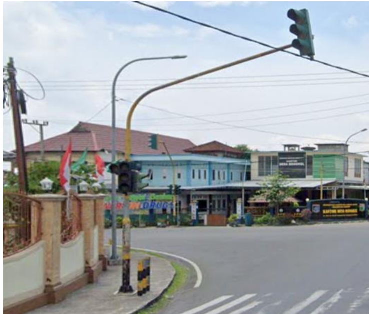
Gambar 13. Lampu Lalu Lintas yang Sudah Tidak Berfungsi
